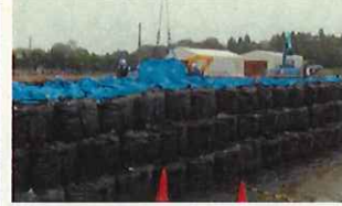
保管場への定置作業
