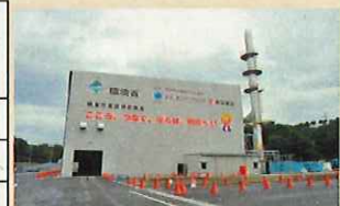
楢葉町の仮設焼却施設(平成28年10月)
