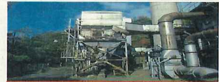
老朽化して休止した処理施設 34
