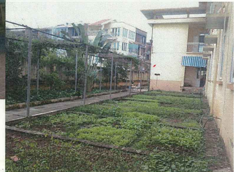
浄化槽設置場所(着工前)
