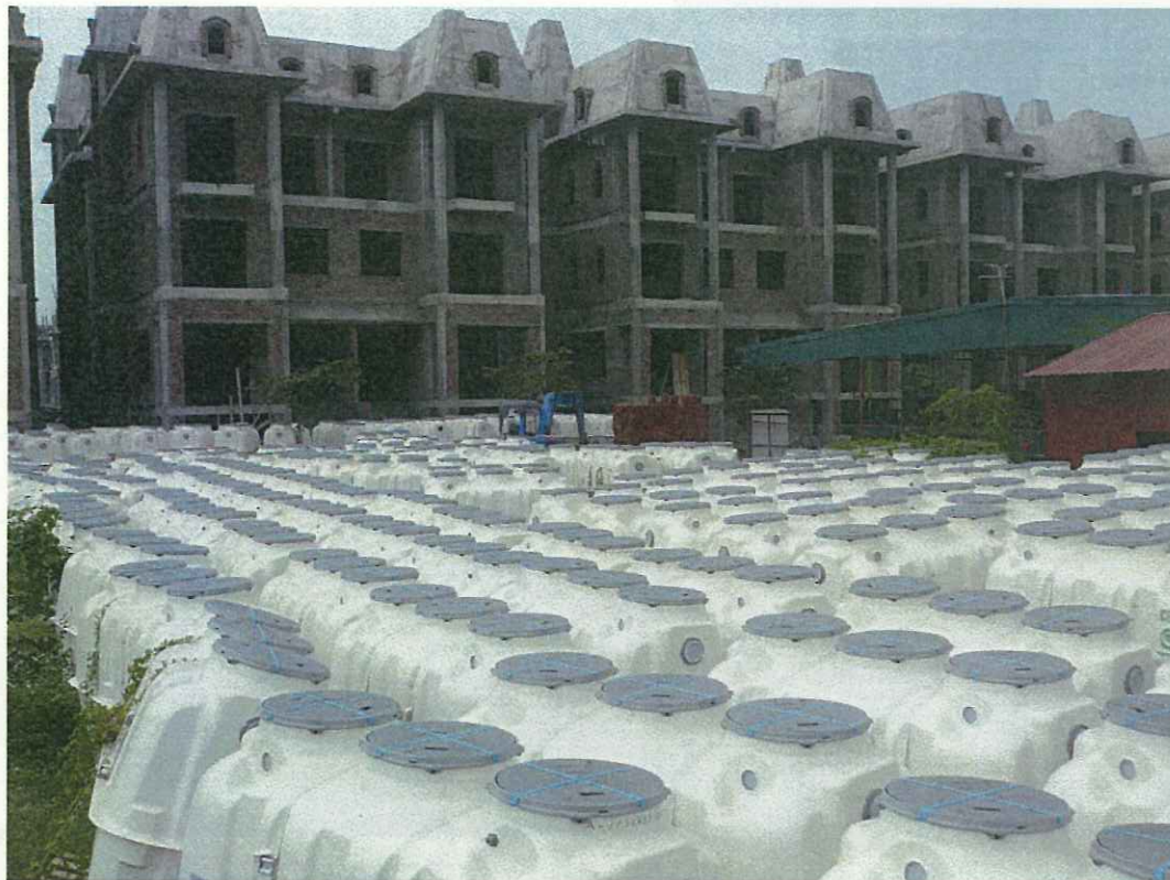
施工を待つ浄化槽 CE5型
