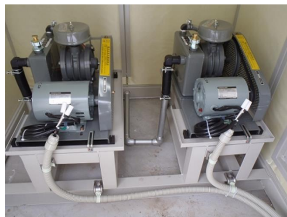
新設ばっ気ブロワ1台、原水攪拌ブロワ1台
