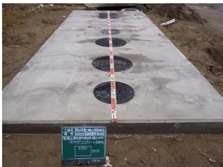
新設浄化槽 上部スラブ仕上げ
